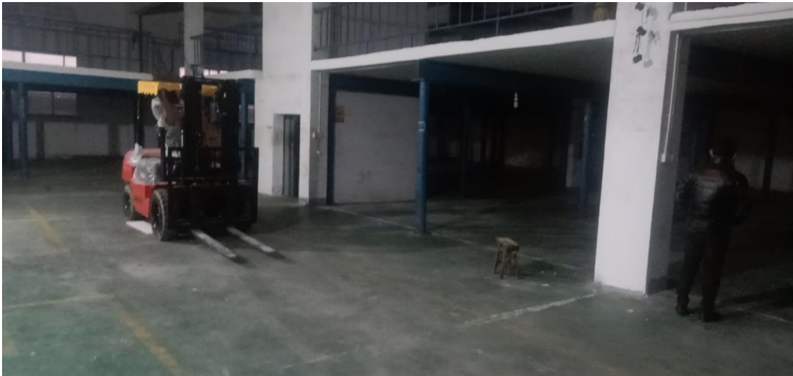
图 1-2 项目车间现场实景 (1)
