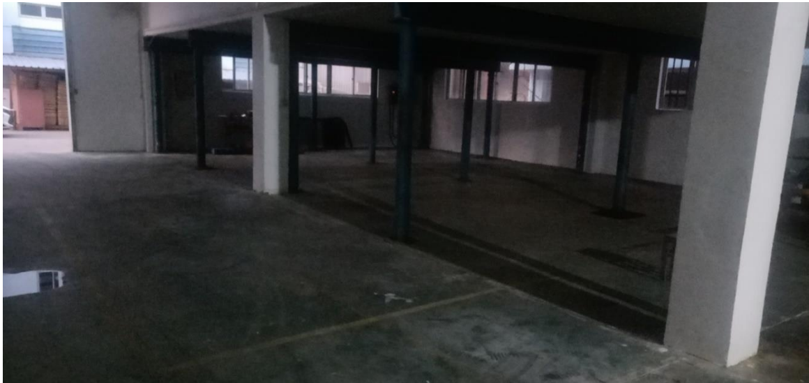
图 1-3 项目车间现场实景 (2)
